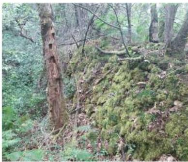
**Figure 2-6 : Vue depuis la rive gauche – arbre dans le parement aval**
