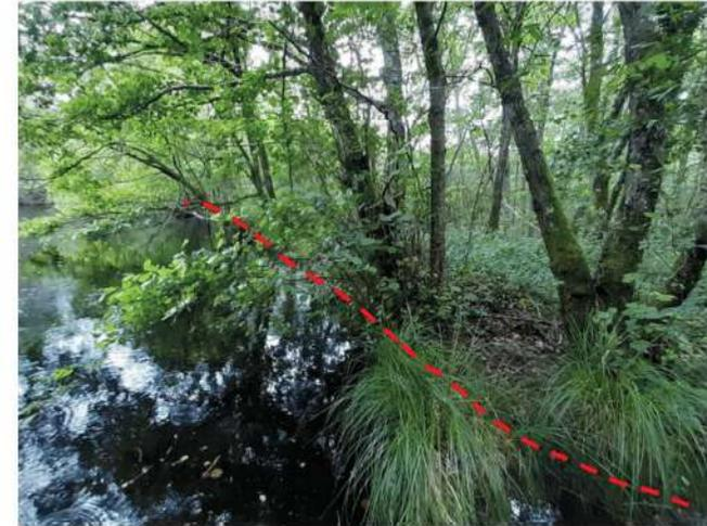
Figure 2-23 : parement amont non visible et très végétalisé
