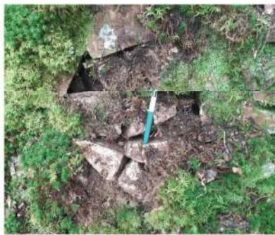
**Figure 2-7 : Pierres sèche constituant le parement aval - végétation**
